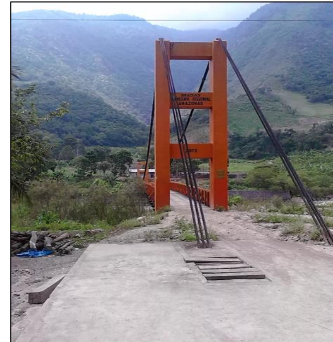
Puente construido el año 2014 para conectar los pueblos de San Isidro , Aserradero y pueblos aledaños. Fuente: foto del autor
