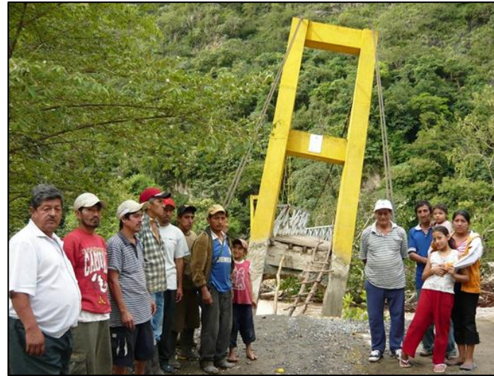
Días después del desastre pobladores acondicionan el puente para conectarse entre los pueblos de San Isidro y el Aserradero, los pobladores usaron este puente hasta el 2014 poniendo en peligro sus vidas. Fuente: foto de poblador
