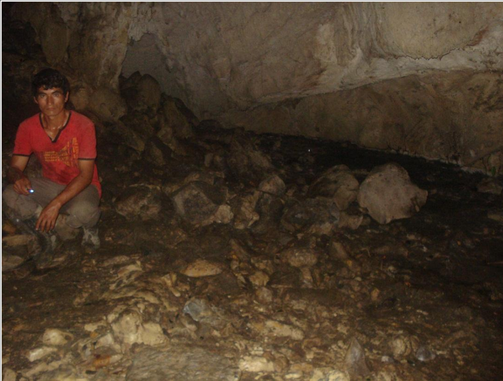
Desprendimiento de bloques.
