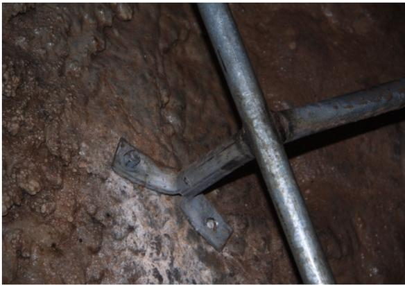
Foto 2: Escalera en la galería fósil de Humajalanta. A la derecha el detalle muestra la mala realización de la obra. La escalera es inclinada lo que pone su utilización peligrosa. Este tipo de obra a pesar de tener un impacto poco agraciado a la vista del espectáculo subterráneo puede hacer correr mas peligro a los visitantes (nada de protección es una mejor protección que una mala protección). Fotos Pouilly, 11-2008.
