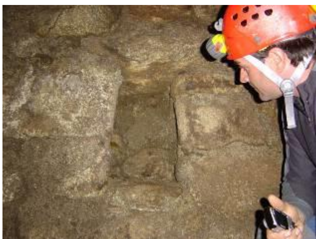
Nicho construido en el interior de la cavidad
