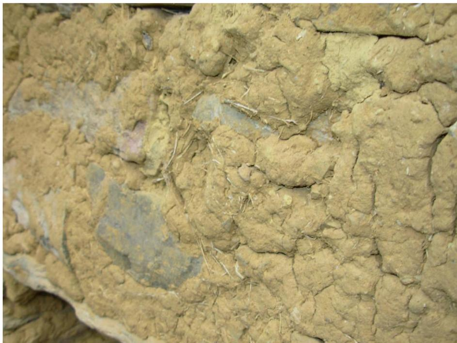
*Figura 18. Foto del enlucido de la chullpa 4 de Los Pinchudos mostrando el craquelado y la paja incluida en la mezcla.*
