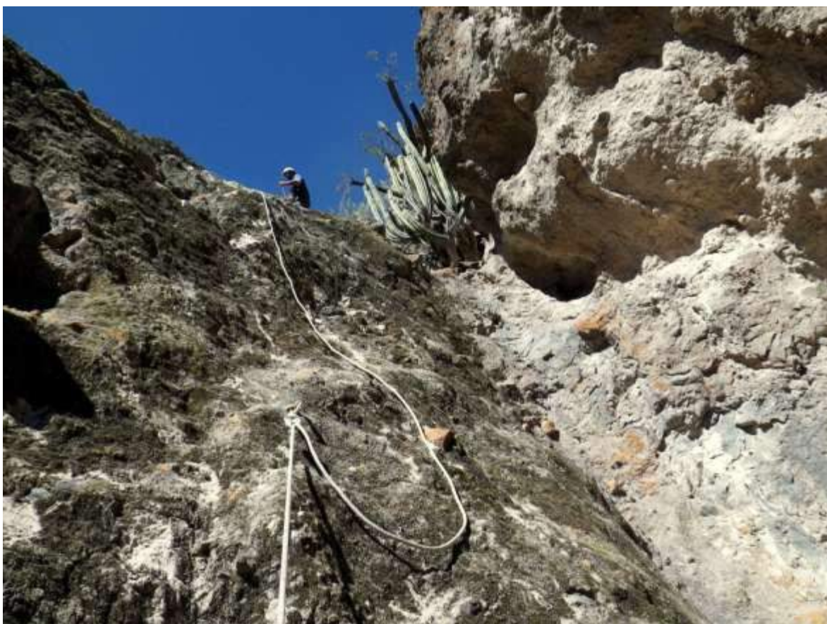
Foto 17 (Aldo Bolaños). Sonccoquilla, Erosión por la escorrentía natural de drenaje en la garganta sin restos de trabajos de acondicionamiento.
