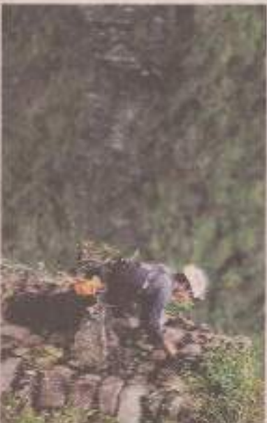
EL ARTE. Fotografía de Asarte con un arnés para explorar nuevas zonas de restauración sin cubrirse por la lluvia alta.
