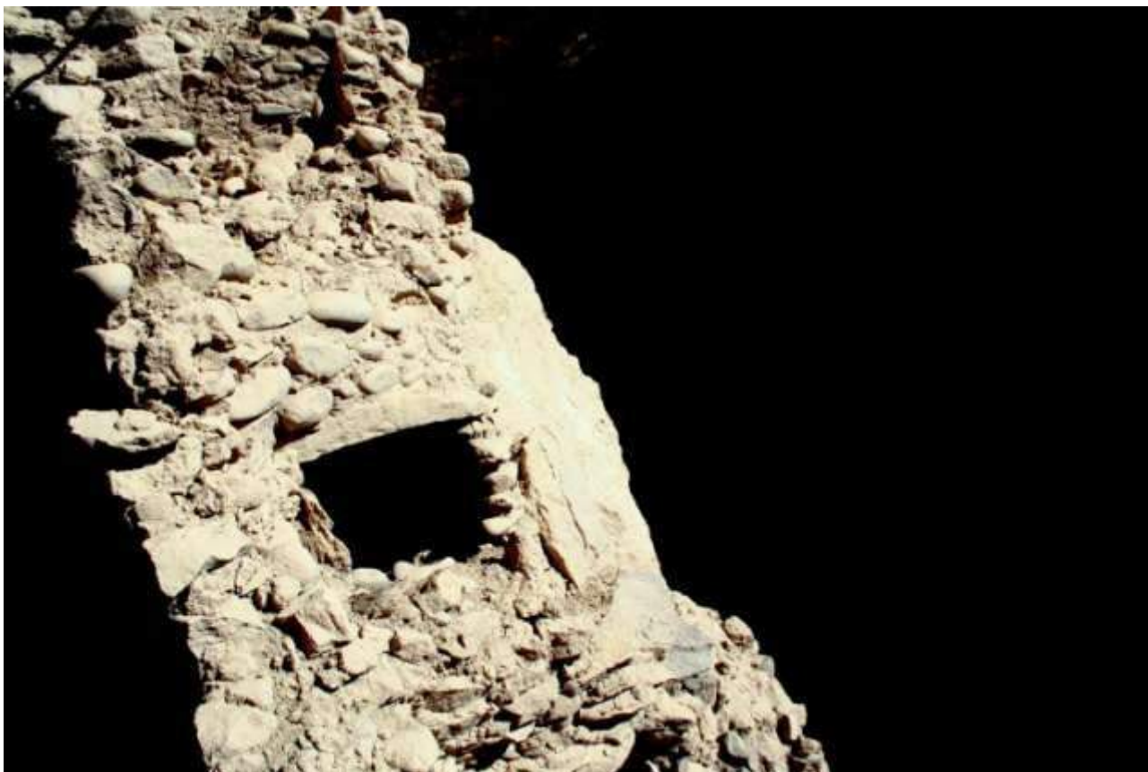
Foto 15 (Aldo Bolaños). . Chininea. Detalle constructivo de pared masiva y muro con vano o ventana.
