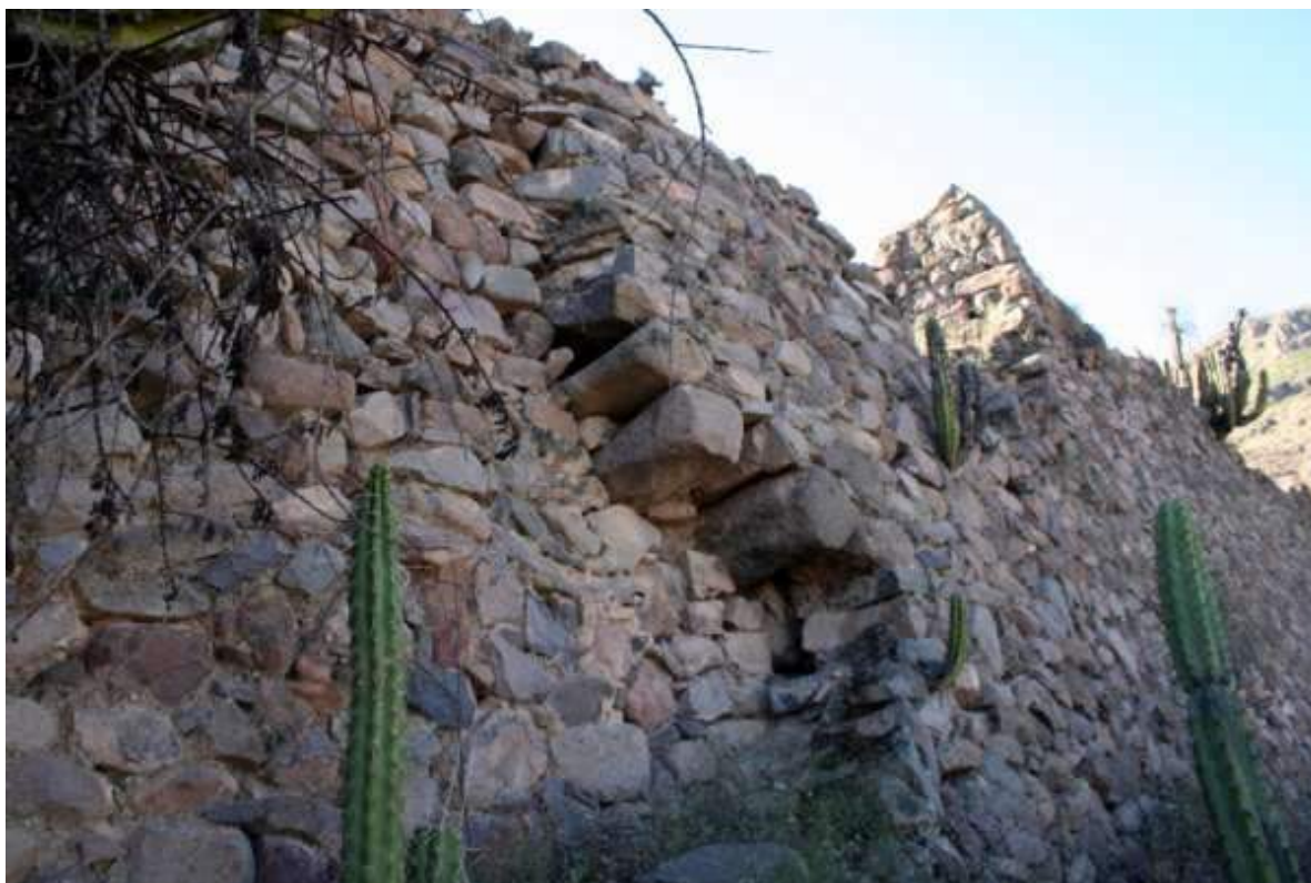
Foto 6 (Aldo Bolaños). Sonccoquilla, Sistema de empalme de muros de las plataformas del sector norte en la cumbre.
