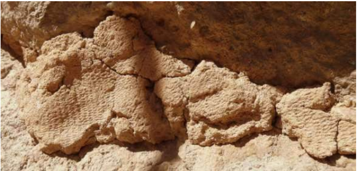
Foto 30 Ismael Mejía). Impronta de tela o cesto de fibra usado para transportar el mortero del muro y colocarlo en el muro
