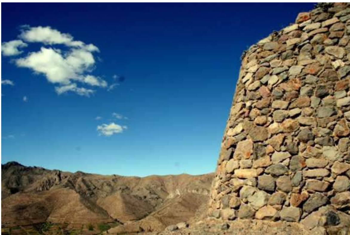
Foto 9 (Aldo Bolaños). Sonccoquilla, muro de plataforma de 4 m de altura en el sector norte de la cumbre. Su paramento exterior fue registrado por el proyecto.
