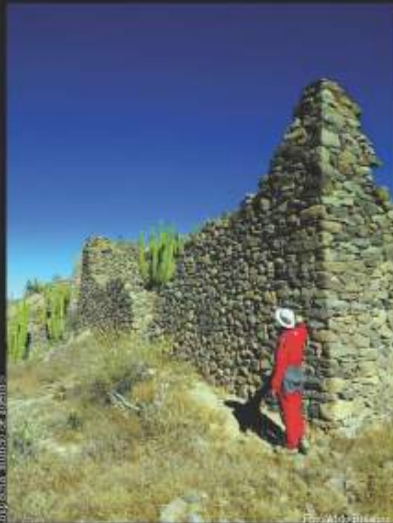
Empalme de muros. Detalle constructivo de origen Wari (500 – 900 d.C.)
