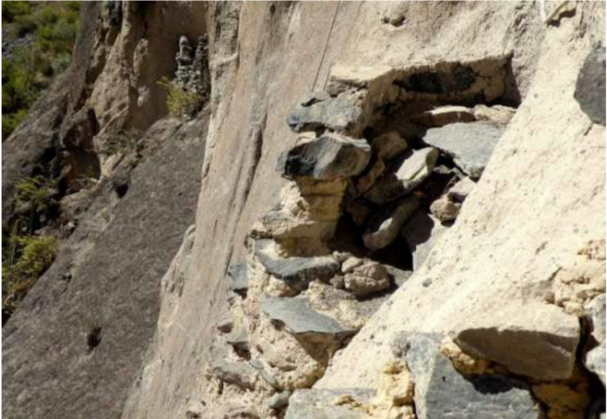
Foto 29. (Patrick Vogin). Choquetico, sector I. Detalle de restos de muro de tumba con alveolo en la pared vertical.
