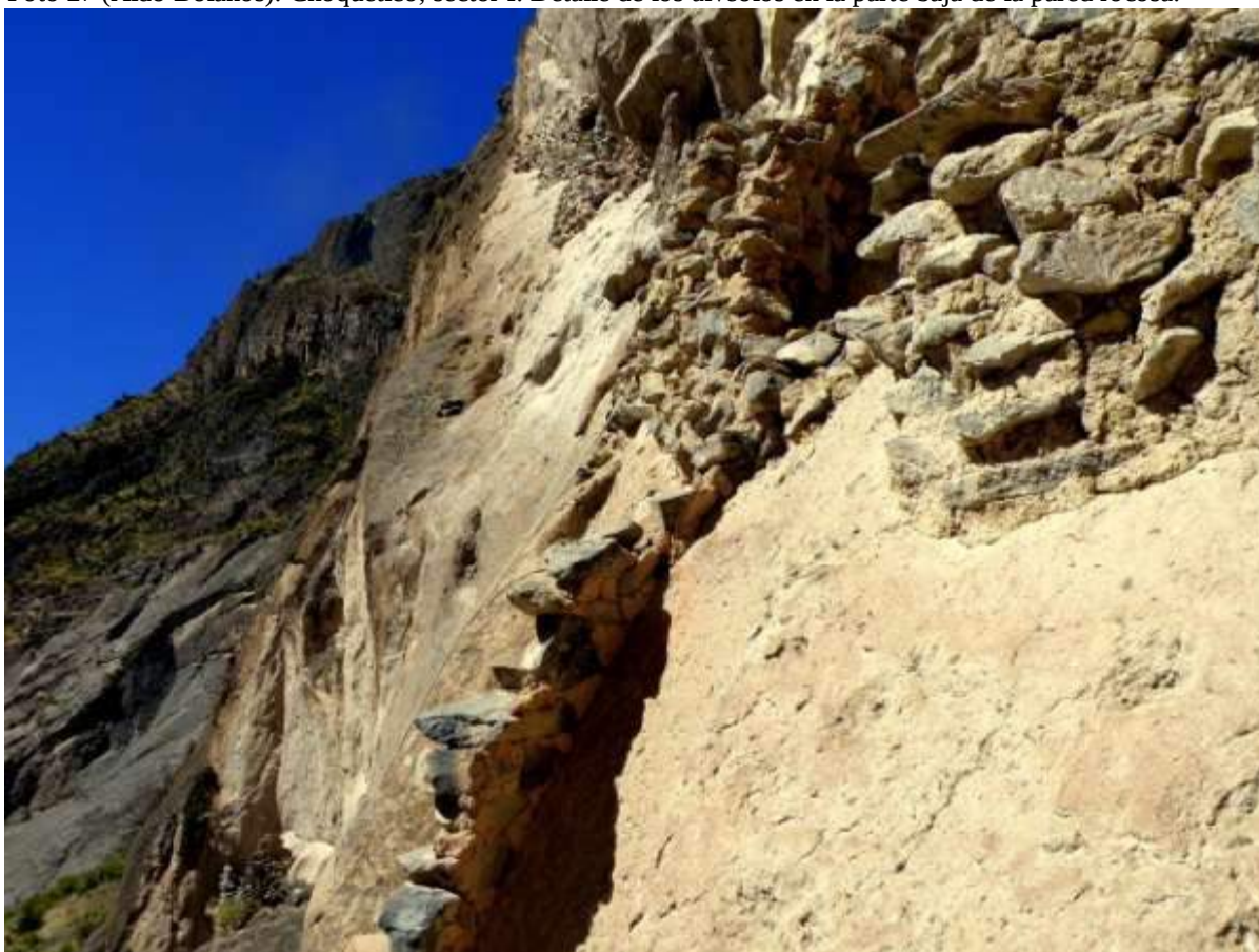
Foto 28 (Patrick Vogin). Choquetico, sector I. Detalle constructivo en la pared inclinada. Baja. Muros delgados y más mortero que piedras.
