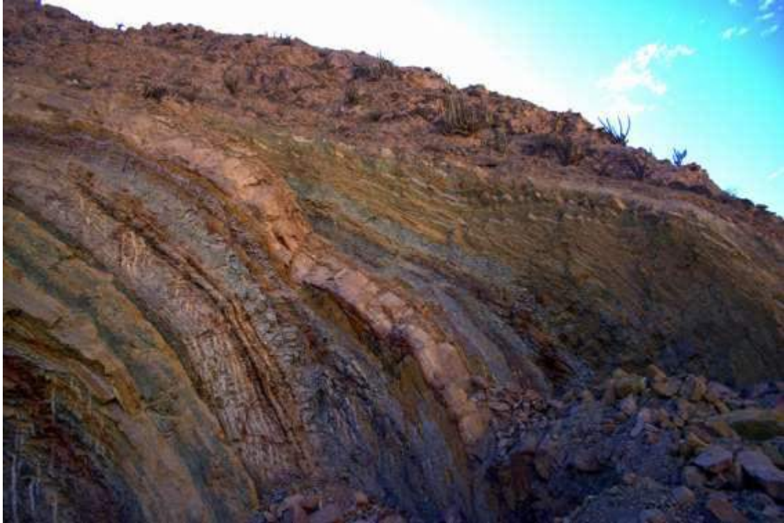
Foto 15 (Aldo Bolaños). Camino a Huanca, grandes formaciones de arcilla que revelan el dinamismo geológico de la región, cortadas por obras para carretera
