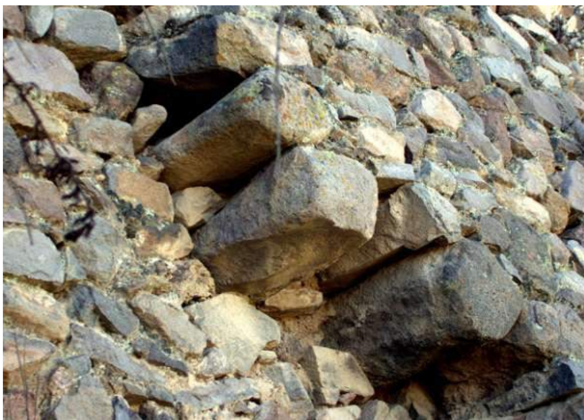
Foto 7 (Aldo Bolaños). Sonccoquilla, detalle de los “tornillos de piedra” de empalme de los muros de las plataformas.
