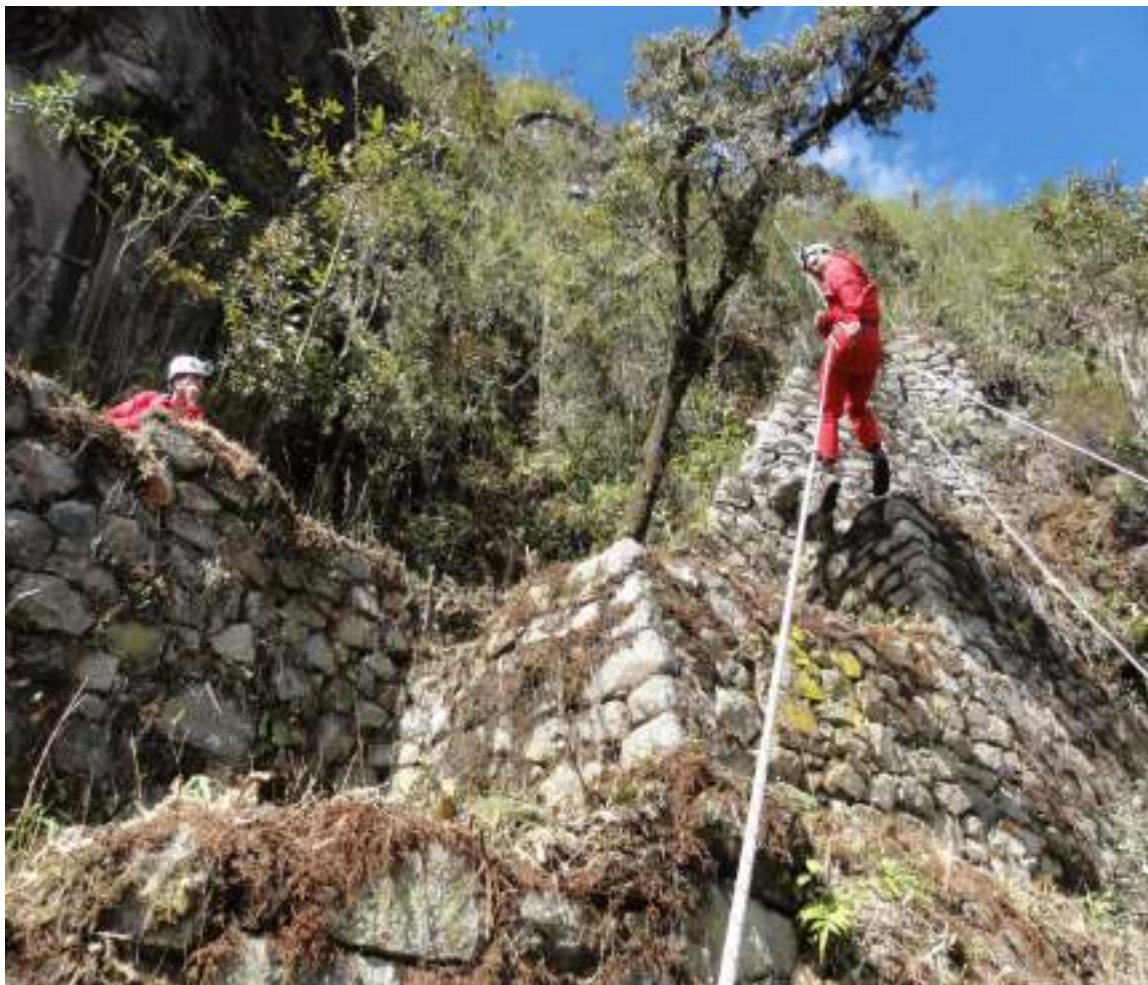
Toma de fotografías del camino hallado en la parte superior del camino del puente Inca .
