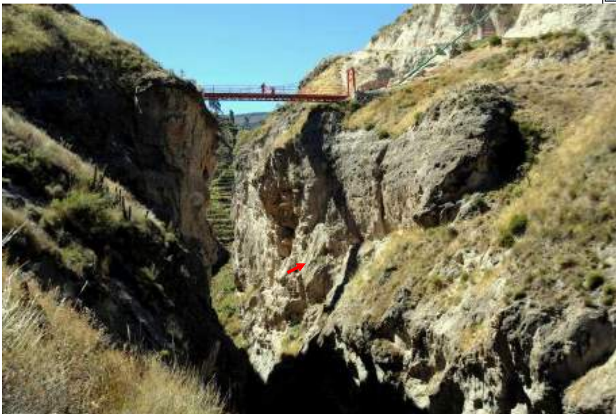
Foto 1 (Arnaldo Ramos). Chininea. Vista del puente sifón desde la parte baja. La flecha roja señala la ubicación del sitio bajo este.
