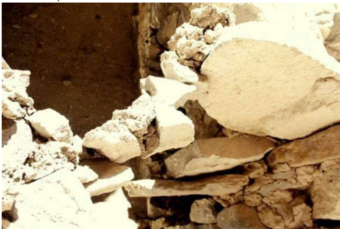
Foto 18 (Aldo Bolaños)- Chininea. Laja base de un muro es sostenida débilmente por un “puente de piedras”..
