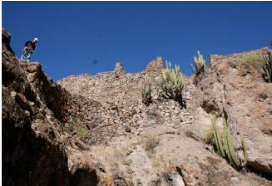
Muros en la parte superior de la zona
