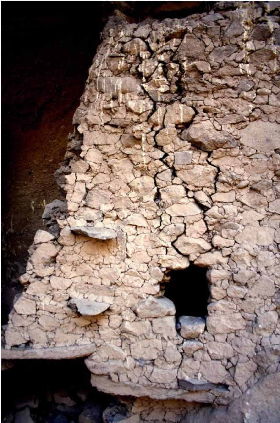
Foto 16 (Aldo Bolaños). Chininea. Estado de conservación de muro. Grieta central y soporte debilitado.
