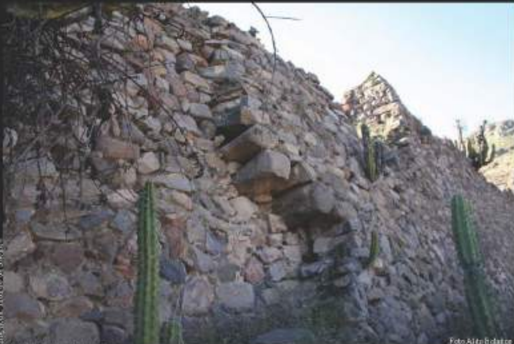
Empalme de muros. Detalle constructivo de origen Wari (500 – 900 d.C.)
