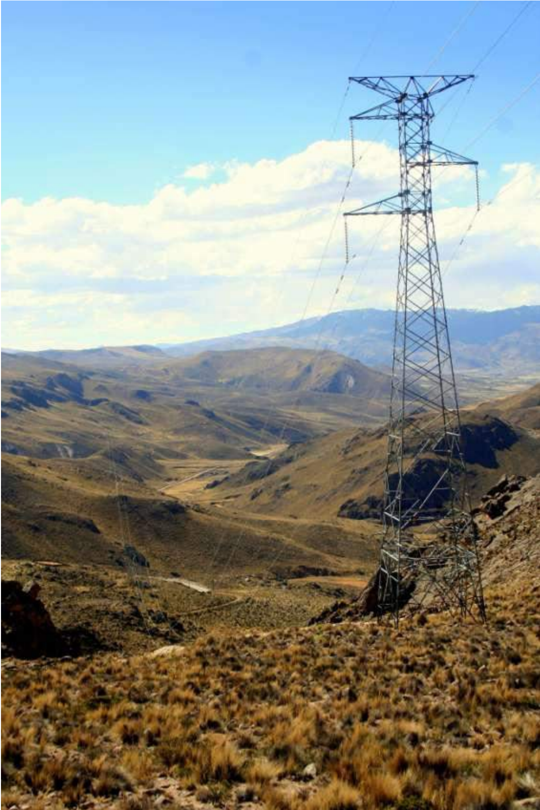
Foto 10 (Aldo Bolaños). El transporte de la energía eléctrica atravesando quebradas y cañones profundos, condicionado por las laderas y cumbres es uno de los retos contemporáneos principales de la verticalidad andina.
