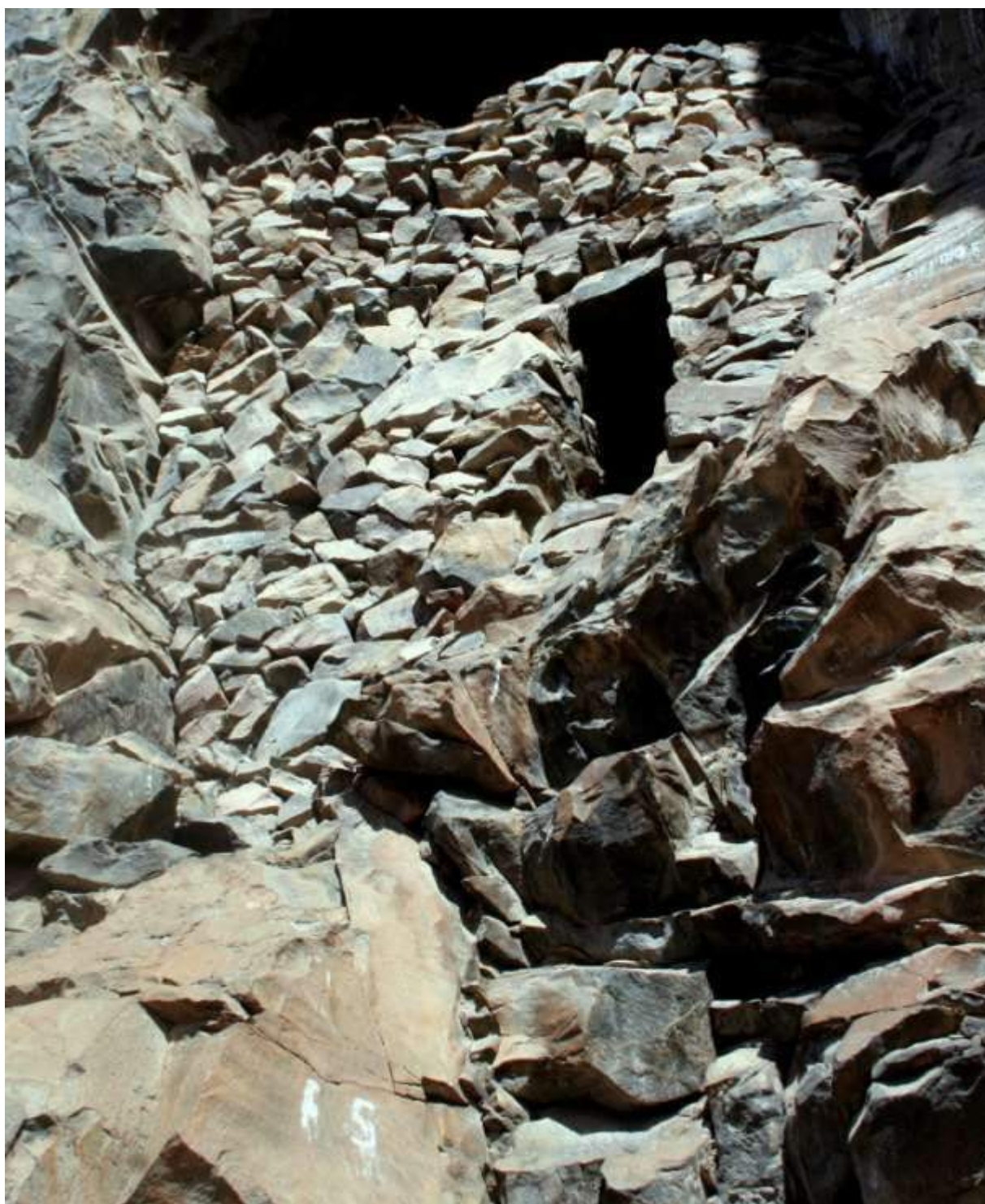
Foto 7 (Aldo Bolaños). Pumunuta, entrada difícil de la segunda cueva. La construcción del muro requirió de cuerdas y andamios.
