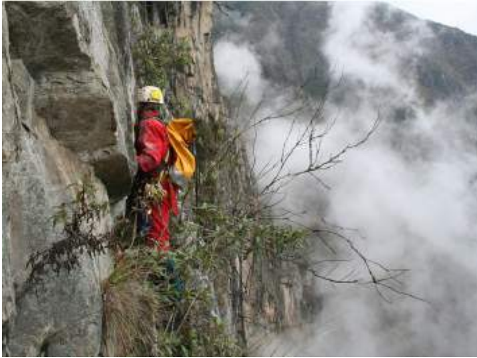
Trabajos en el camino del puente Inca Cerro Machupicchu.
