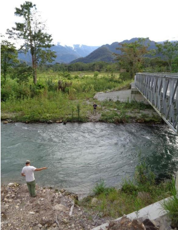
Figure 4 - Jaugeage du rio Negro à l'ADCP, nouvelle section
