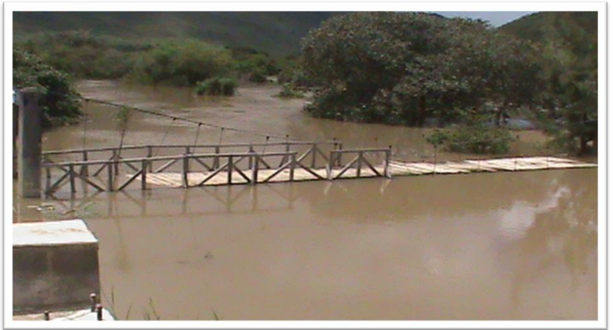
Ilustración 4: Distrito Chirimoto, Puente peatonal en peligro por la Inundación del Río Shocol
